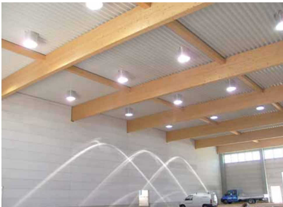
N. 14 SOLARSPOT 650, di configurazione molto complessa, composta da 22 sezioni tubolari, illuminano la superficie di 560 m 2 dell'ampliamento dello stabilimento FRE.TOR, Puos d'Alpago (Belluno) Italia. (anni 2001)
