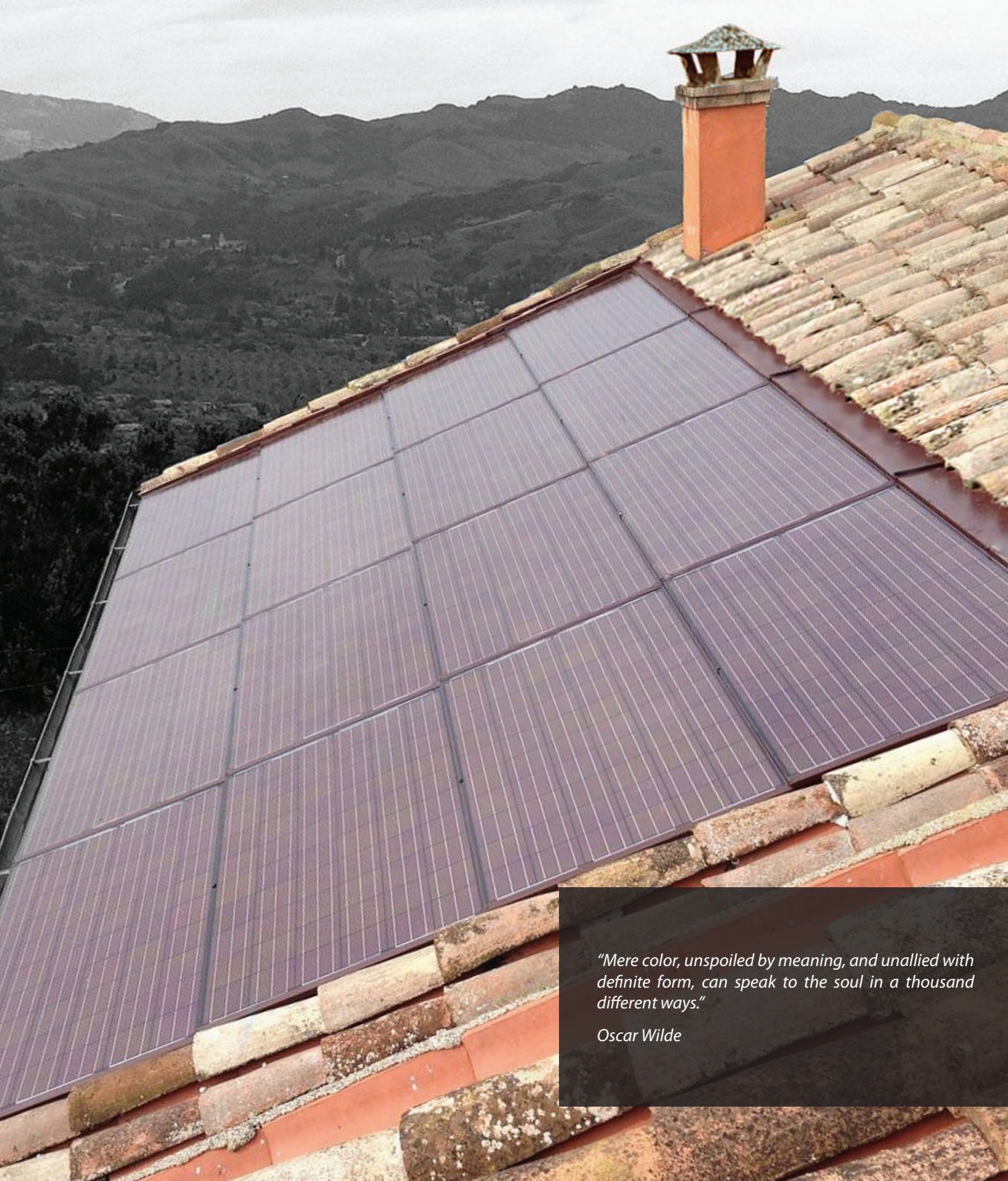
Dettaglio della specifica cornice BIPV (Solrif®)
